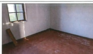
Chambre cheminée avec
