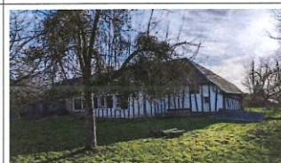
Pignon arrière et façade
