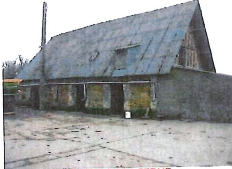
MAISON DE LA FERME
