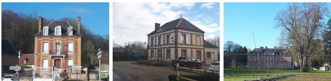
Photo 8. Eléments du patrimoine bâti recensés
